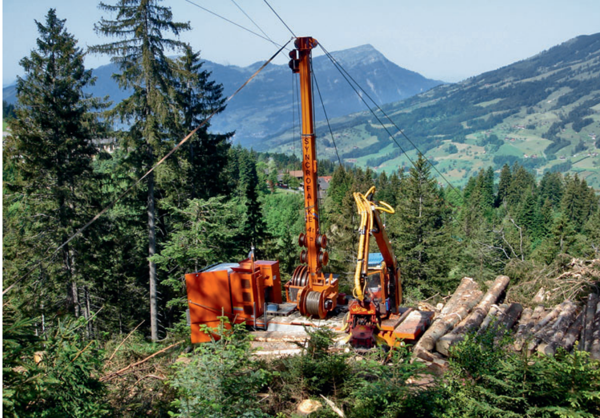
Abb 1 Kombiseilgerät im Einsatz.
